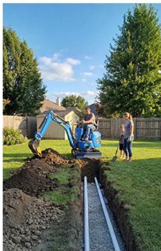
DIG DRAINAGE DITCHES
